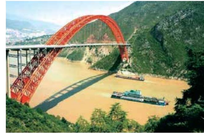
Bơm tính Sany thi công cây cầu Trường Giang
